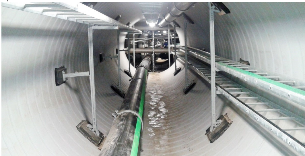
Tubería de residuos MetroTaifun con la línea verde instalada en el infra-tunnel.
