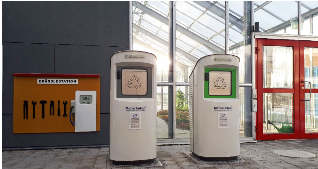
Entradas de recogida de basura con básculas en Vallastaden.
